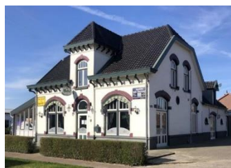
Zelhem, voormalig stationskoffiehuis, architect, Jacob Post
