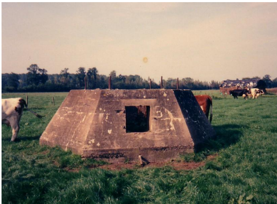
Betonnen voet van Würzburg Riese aan de Beekstraat
