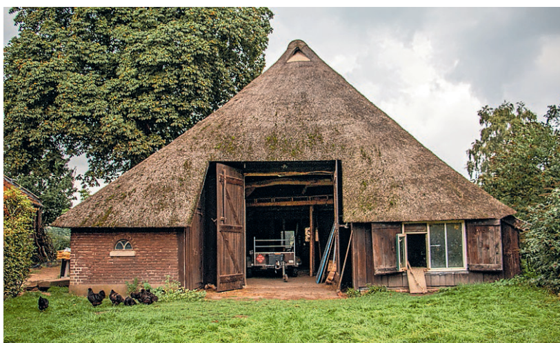
De boerderij, inclusief schuur naast de boerderij en de parapluberg aan de Zelstweg in Vorden is een gemeentelijk monument, daterend tweede helft 19de eeuw. Foto: Liesbeth Spaansen
