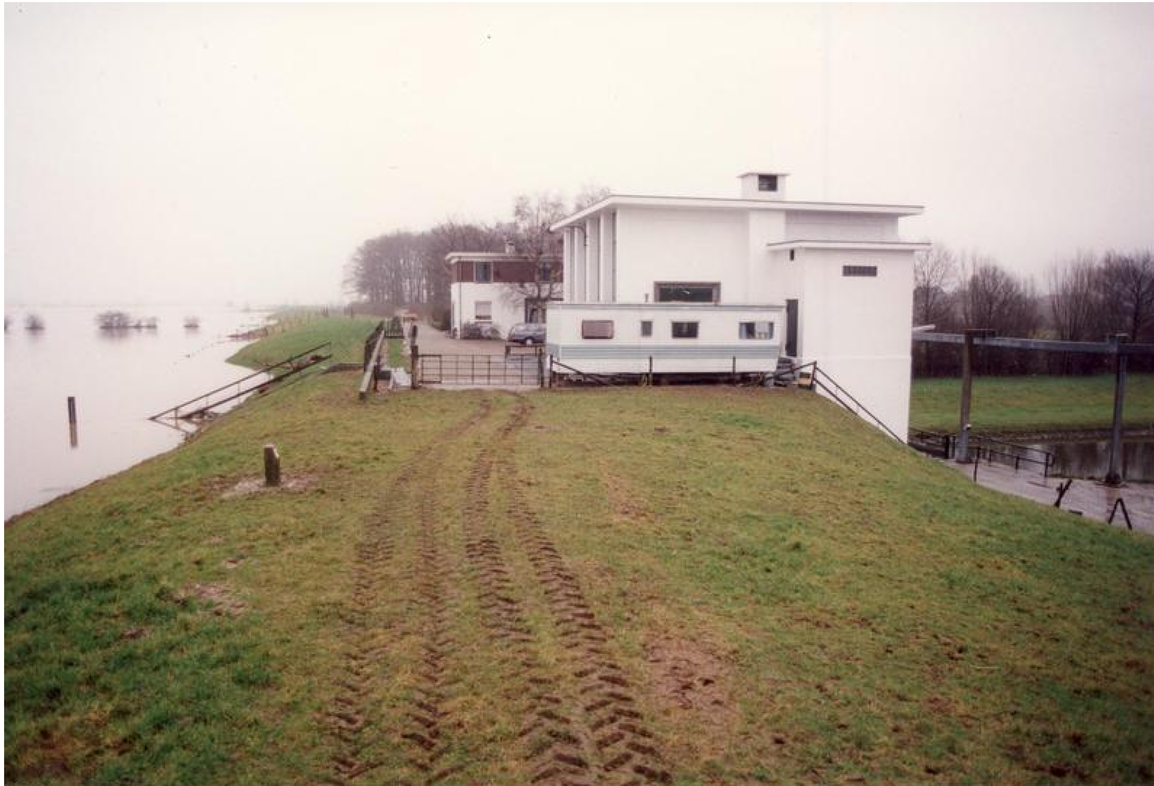
Een monumentaal gemaal
